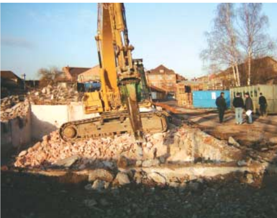
Área urbana deteriorada
