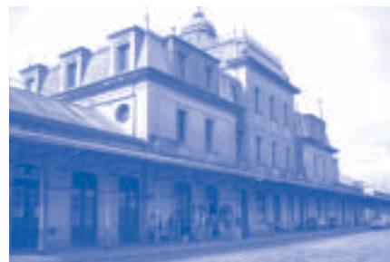
Estación central Córdoba
