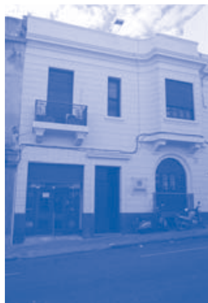
Montevideo. Fachada renovada
