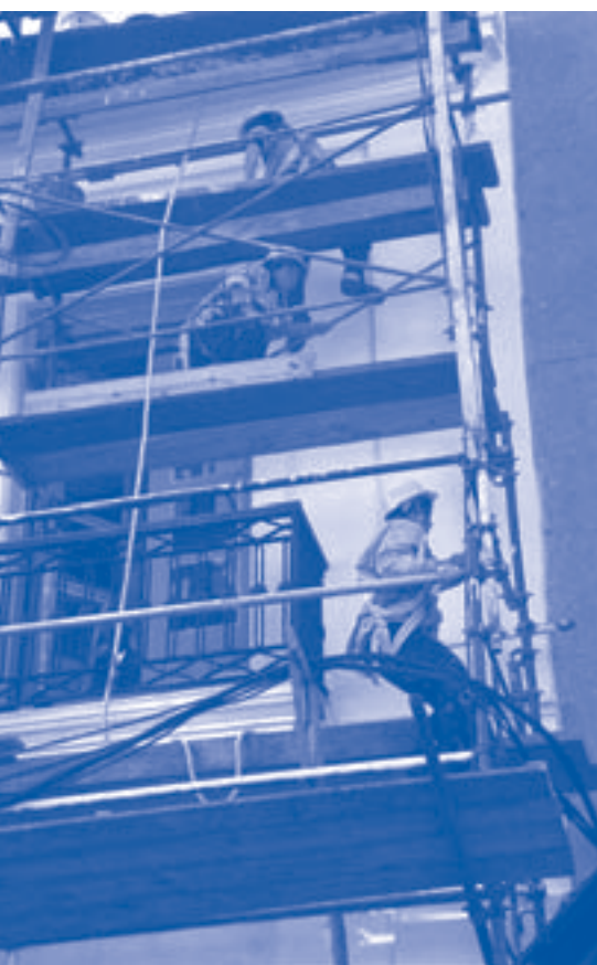
Montevideo. Fachada en obra
