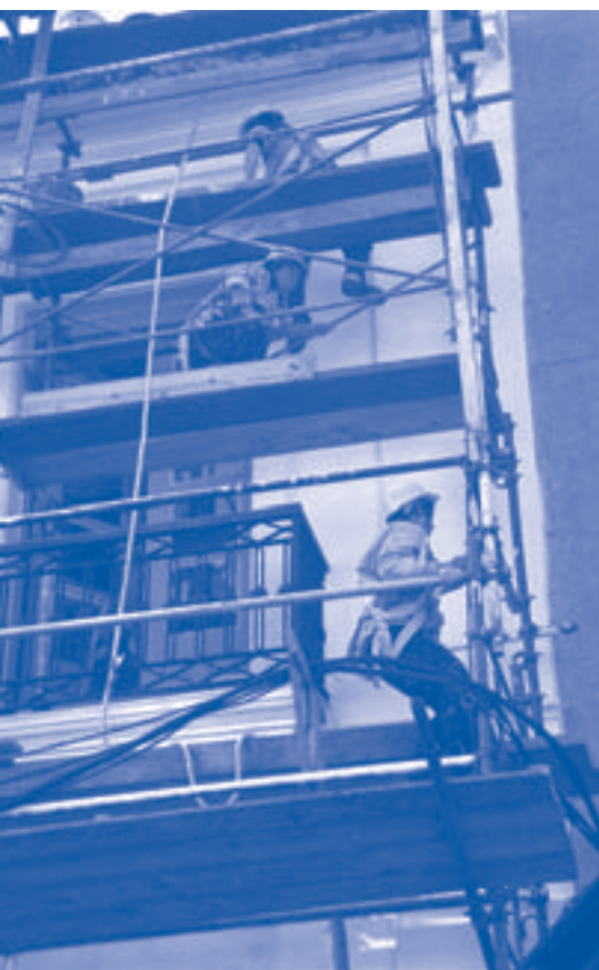
Montevideo. Façade en travaux.
