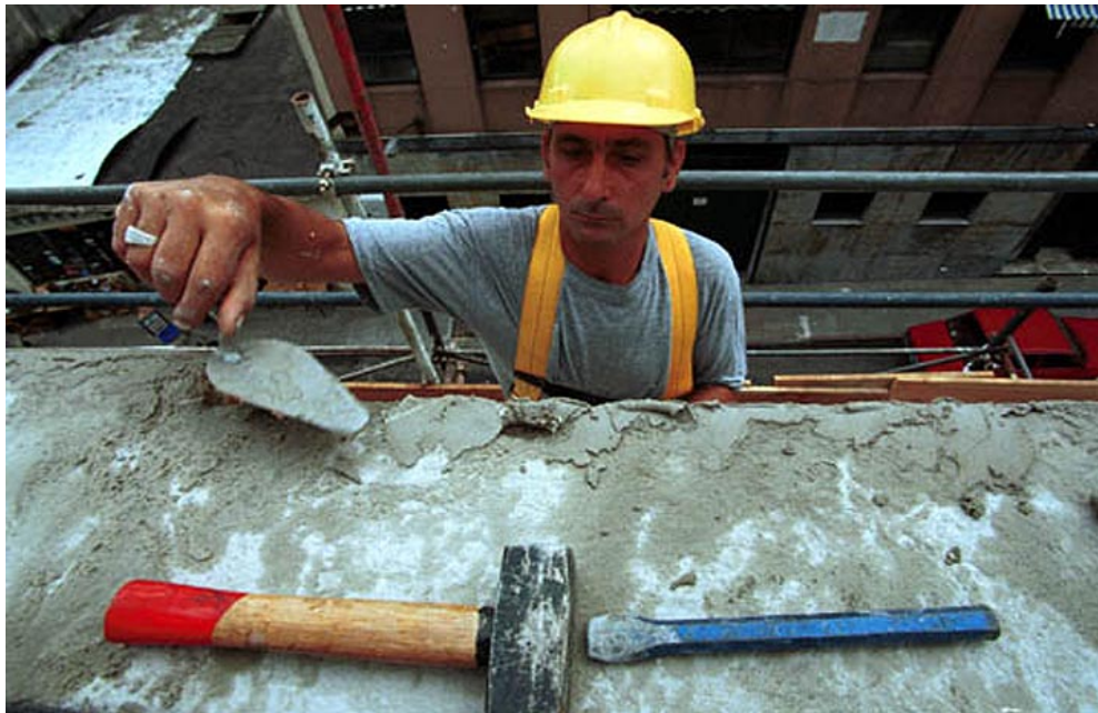
Las primeras fachadas en obra. Calle Treinta y tres 1521.
